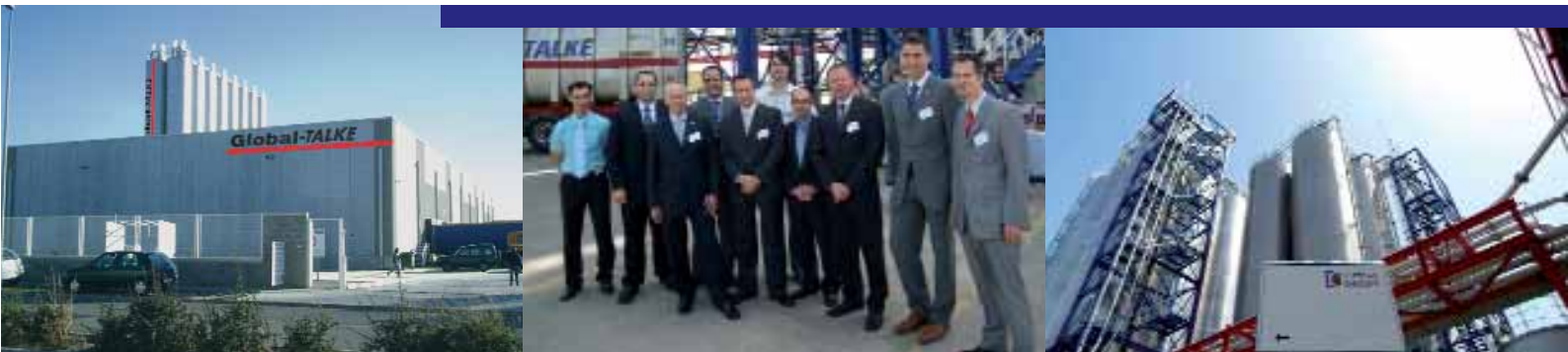
Die neue Siloanlage in Tarragona; Dr. Stefan Michel, General Manager Lustran Polymers (3. v.r.), Armin Talke (3. v.l.), Alfred Talke (5. v.l.), Mitarbeiter bei der Eröffnung
